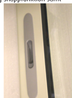
Hakregellås med invändigt infälld snäppfunktion
