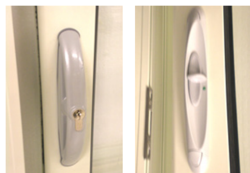
Hakregellås med invändig snäppfunktion samt cylinderlås
