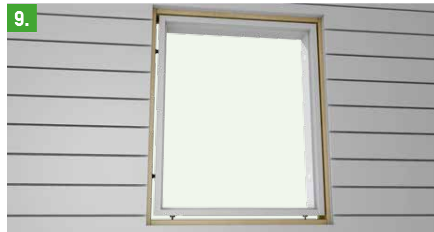
9. Isolera spalten mellan vägg och karm med Fogskum Flex Pro, alternativt isolera med glasull.
