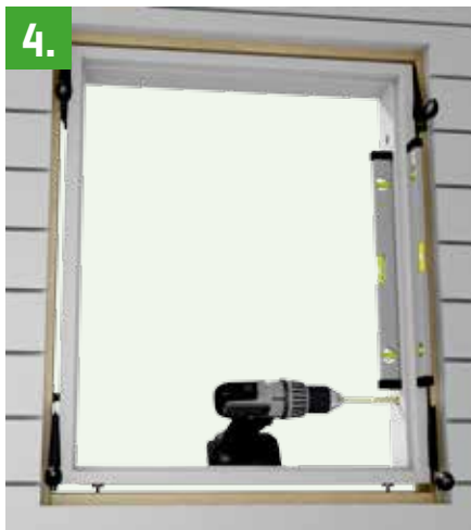
4. Skruva ut de två nedersta hylsorna på var sida mot väggen.
