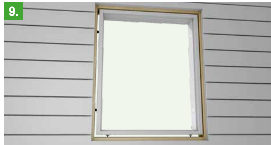
9. Isolera spalten mellan vägg och karm med Fogsukum Flex Pro, alternativt isolera med glasull.
