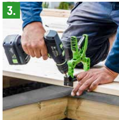
3. Vinkla skruvdragaren så att batteriet inte slår mot trallbrädan, då minskar risken för felmontage samt skador på monteringsverktyg och bits.
